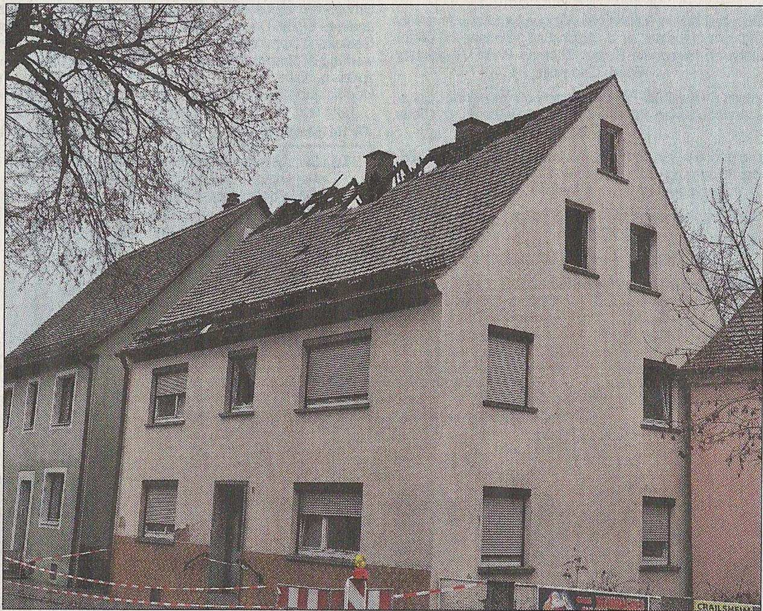
Mit Wasserwänden schützten die Feuerwehren die nahen Nachbarhäuser vor einem Übergreifen des Feuers.
